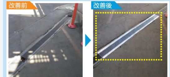
フォークリフト運行路にあるグレーチングの変形により、転倒する危険があったため、耐荷重用グレーチングに交換した。
