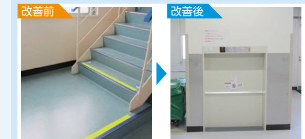
改善前 改善後 階段での荷物運搬は足元の見通しが悪く転倒の危険があったため、荷物専用エレベータを設置した。
