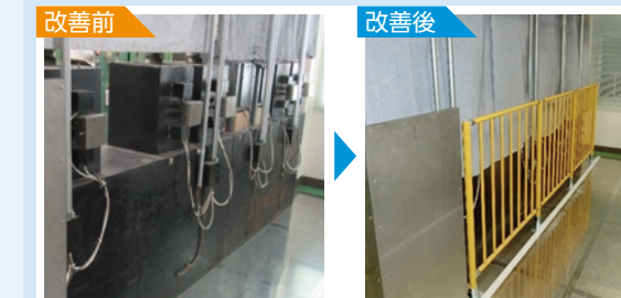
改善前 改善後 露出した電気炉の炉体で火傷の危険があったため、耐熱カーテンと安全柵で覆って人体と高温部の接触をなくした。
